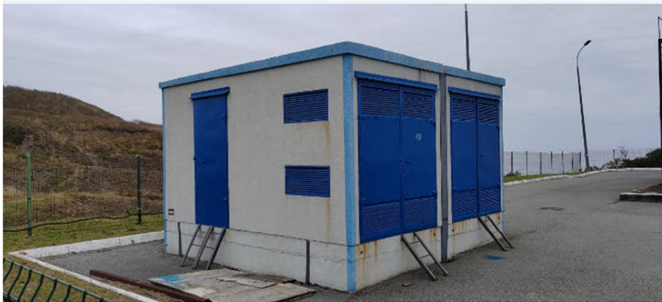
6. Комплектная насосная станция Flo Tenk-KNS-30-47-2
