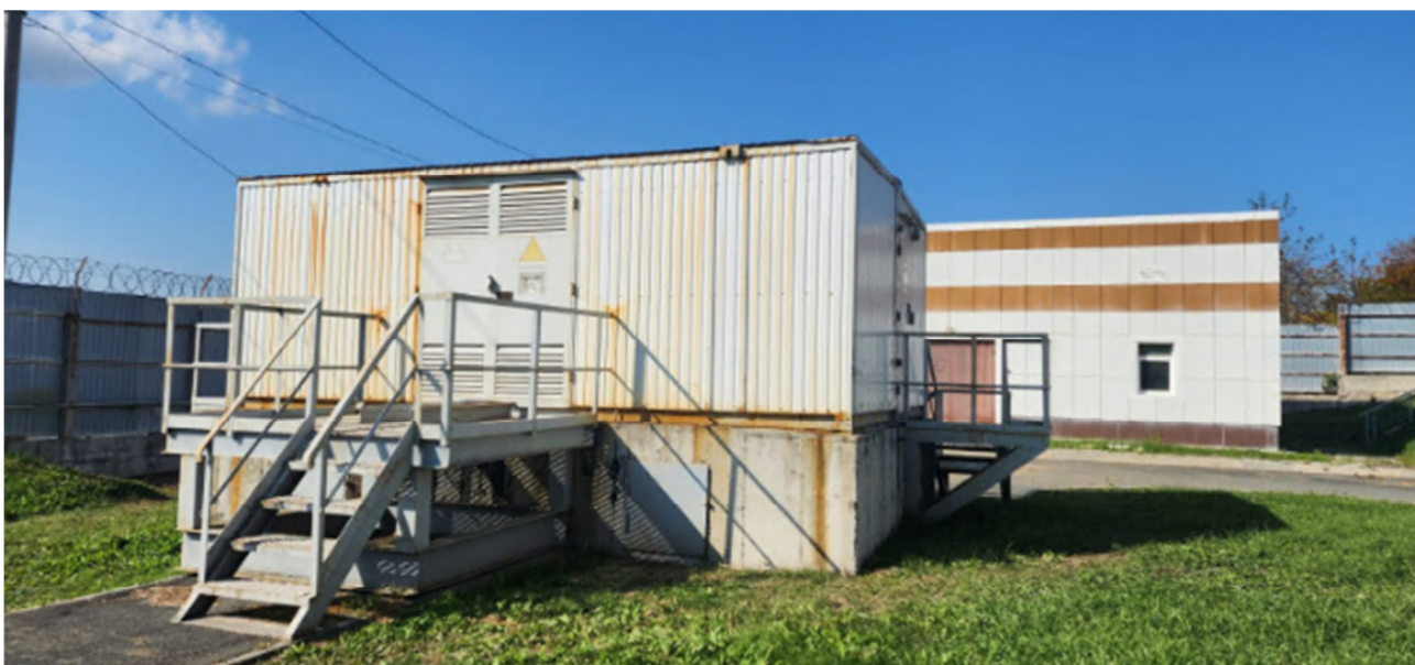
4. Комплектн. трансформаторная подстанция 2 КТП/ТБУ К-К 250/10/0,4 УХЛ 1
